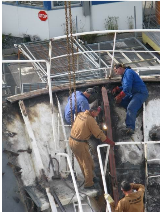
Die Schweißarbeiten dauern an
