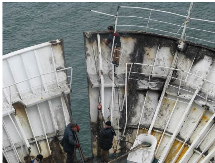
Aus der so genannten Schanz mussten Teile herausgeschweißt werden
